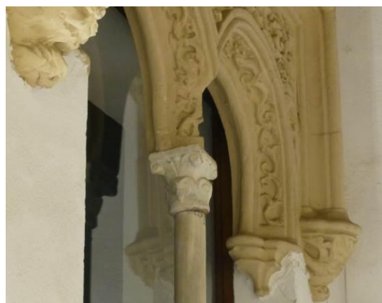
FIGURA 4: Fuste de columna desplazado en el capitel. Patio del Palacio de Pinelo.
