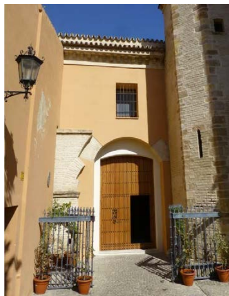
FIGURA 2: Puerta sur de la Iglesia de San Andrés, en la que se puede ver el colapso y posterior reparación del arco de fábrica de ladrillo.
